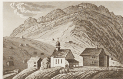
Schwenli, gegen die Alpstiegleten. Schwenli, vers les Alpstiegleten
