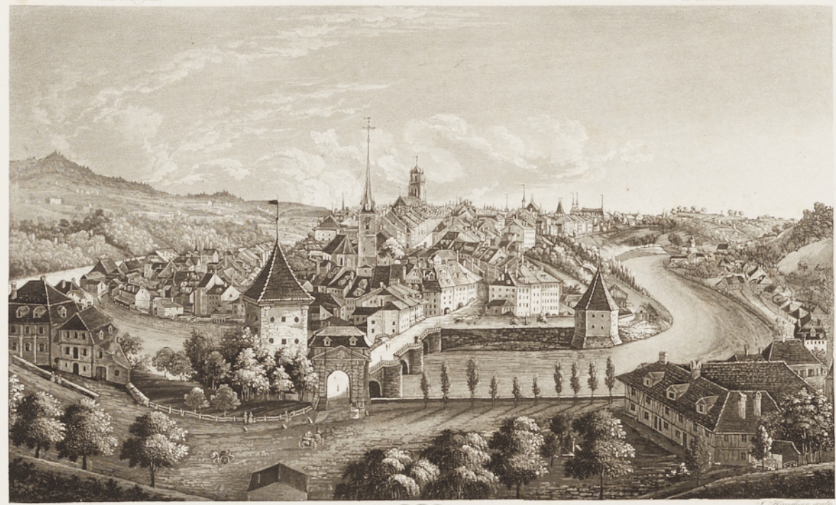
Ansicht der Stadt Bern von der Höhe des Düngr-Spält Vue de la ville de Bern prise de la hauteur de l'Hôpital des Bourgeois
