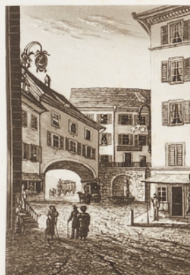
Die neue Einfahrt in die Bäder. Le Saisir nuove aux Bains.
