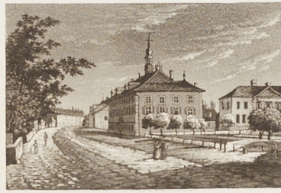
Das Kantonsschul-Gebäude und das Casino. L'École cantonale et le Casino
