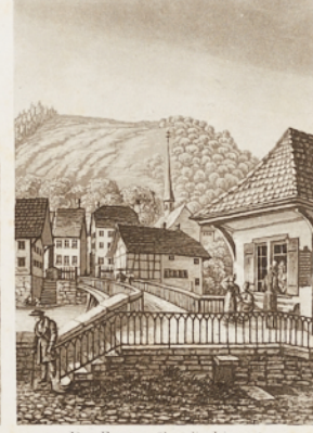
Der Fursteg über die Limmat. Le pont sur la Limmat.
