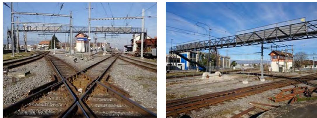
Abb. 1 und 2: Passerelle über die Bahngleise beim Bahnhof in Kerzers FR: Ansicht nach Ausführung der Restaurierungsarbeiten. Fotos: Pio Brönnimann, Herbst 2019
