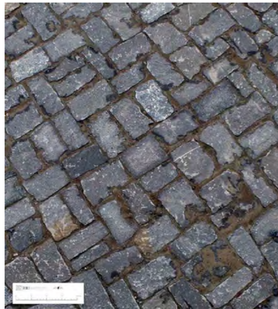
Fig. 12 : Échantillon (1 m 2 ) d'un pavage en grès, dit sauvage, posé en diagonale. Photo : archive de l'auteur
