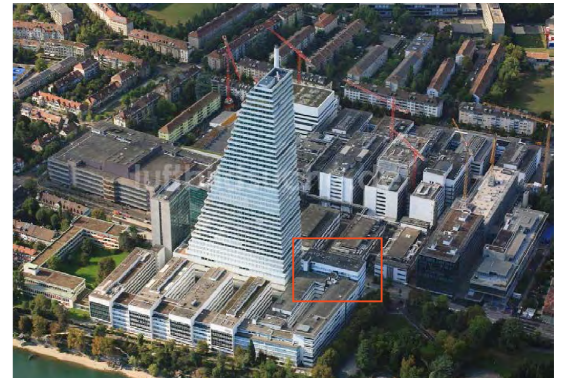
Abb. 5: Heute ist der Bau 27 in das Gesamtareal harmonisch eingebunden.
