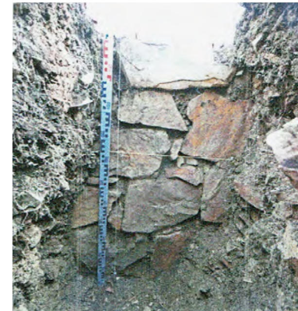
Abb. 4: Ostmauer, Innenseite. Sondage 3.2020. KASH DSC_2892
