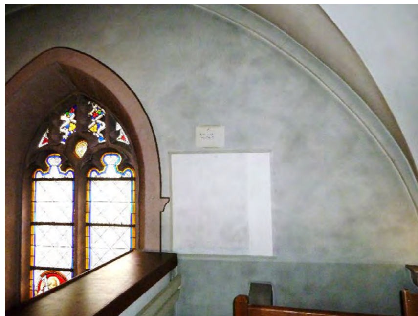
Abb. 4: Muster Innenreinigung auf Empore
