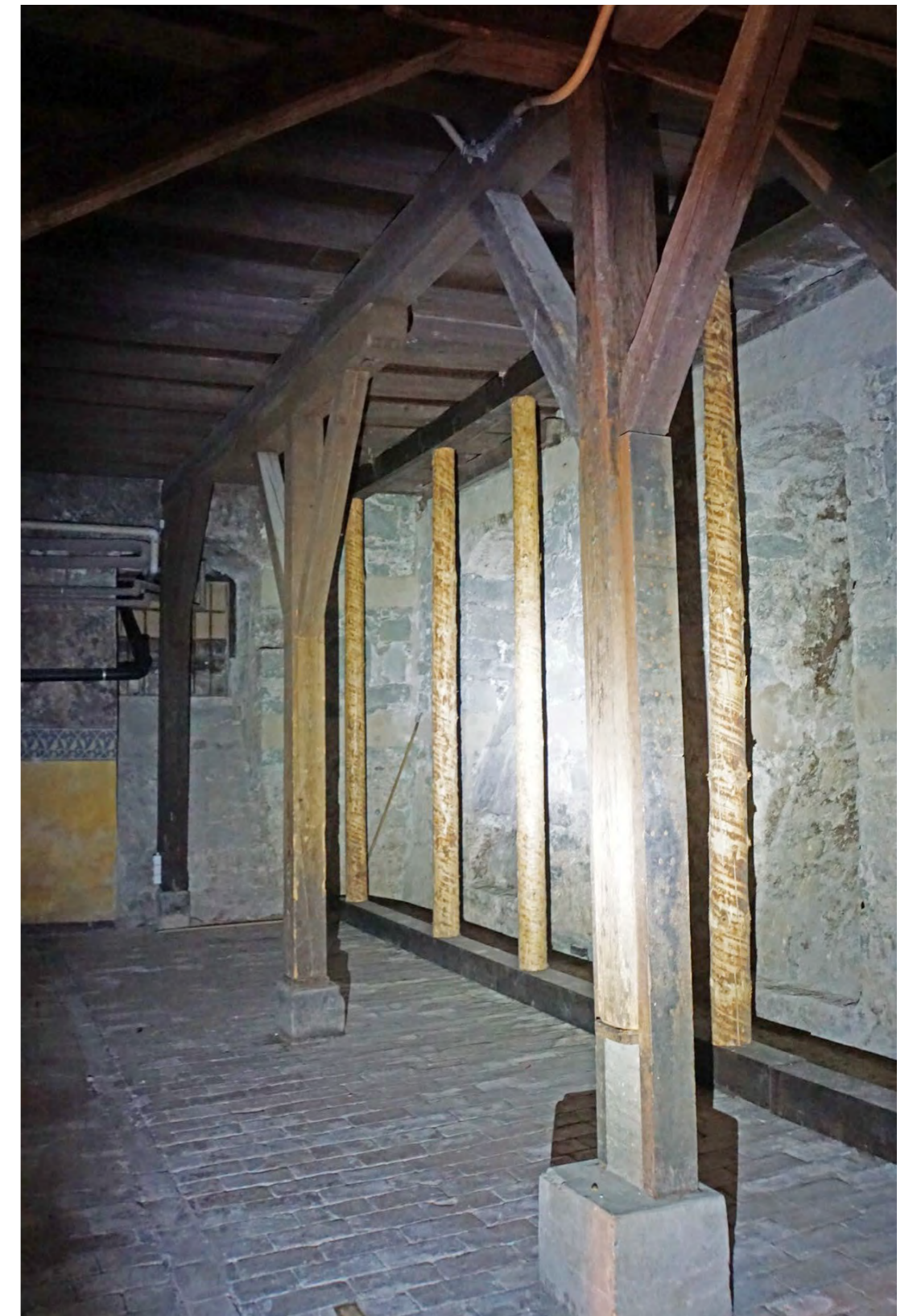
Abb. 3: Nachträglich eingezogene Stützenreihe mit zweitem Unterzug im Kellergeschoss
