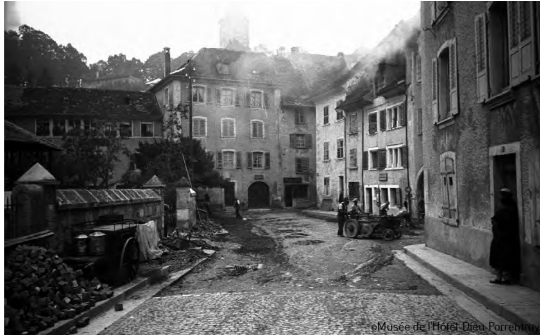
Fig. 23 : Réfection de la Cour-aux-Moines en septembre 1934. La photo montre le remplacement de la chaussée en macadam avec un pavage en grès. Fonds photographique Albert Perronne au Musée de l'Hôtel-Dieu, Porrentruy
