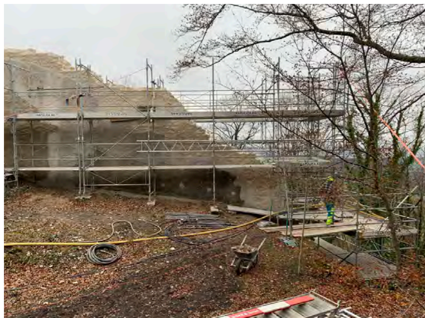
Abb. 7: Sanierte Mauer (M 1), November 2020. Foto: GG
