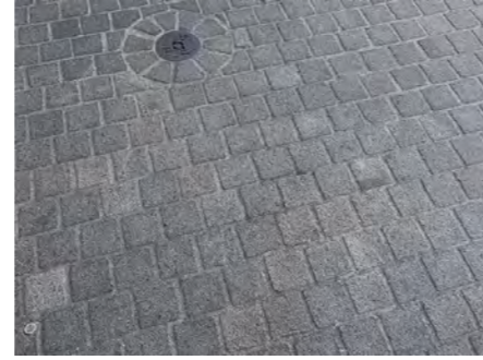
Fig. 7 : Pavés en granit gris clair sciés 9/9/9 et flammés, utilisés à Bülach
