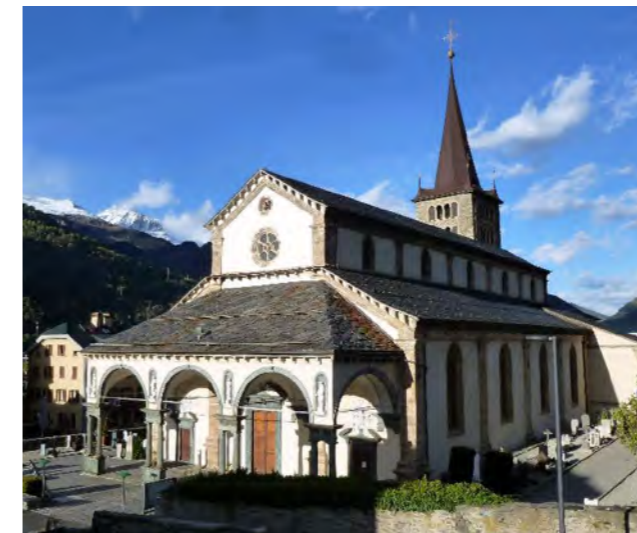
Abb. 1: Aussenansicht von Westen
