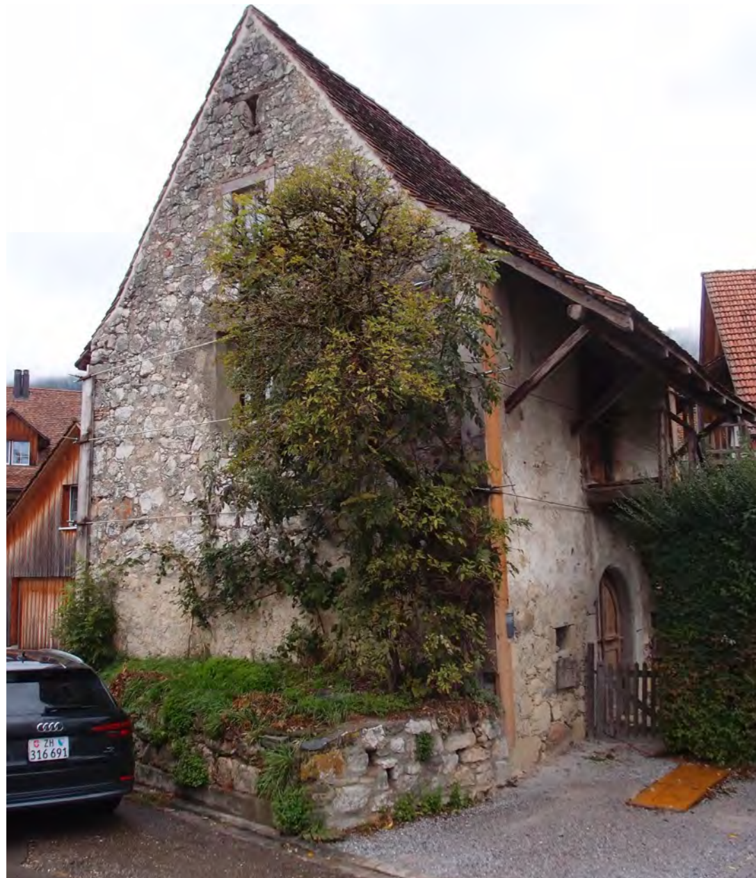
Abb. 2: Ecke Südost, Zustand am 4.10.2019
