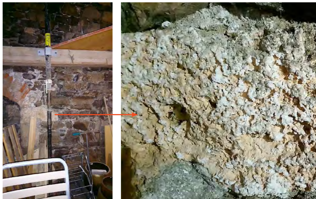
Abb. 5: Entnahmestelle an der Nordwand im Untergeschoss des Torturms (siehe auch Abb. 1)
