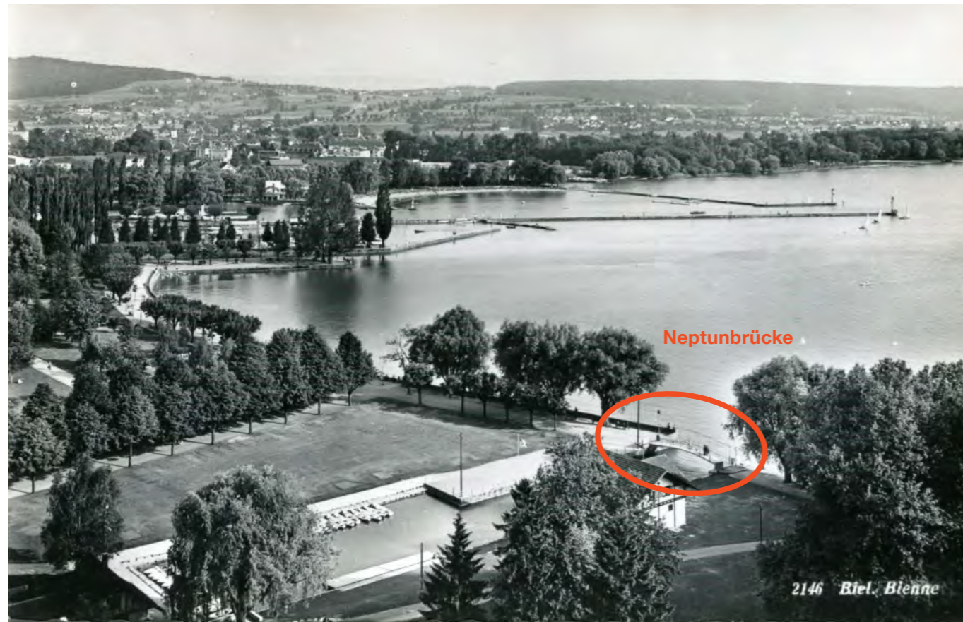
Abb. 6: Aufnahme vermutlich aus der Zeit von 1929 bis 1935. Die Neptunbrücke (rot eingekreist) schliesst südostseitig an die historische Seeufermauer an, die im Nachgang an die erste Juragewässerkorrektion erstellt worden ist. Die Befestigung der Seeuferlinie und die Ausbildung einer Seeuferpromenade nordwestlich der Einmündung des Schüsskanals in den See erfolgten über einen längeren Zeitraum hinweg. In einer ersten Phase handelte es sich nur um eine Seemauer auf Terrainhöhe. Die brüstungshohe Quaimauer wurde erst später realisiert, da die bestehenden Ufermauern bei Sturm und Hochwasser stets überschwemmt wurden (Auftrag schon 1914, Ausführung in der Folge).
