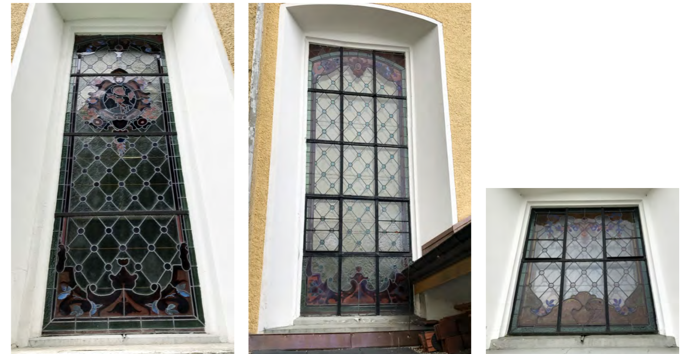
Abb. 2: Aussenansicht der Fenster im Chor, Nordseite und bei der Empore
