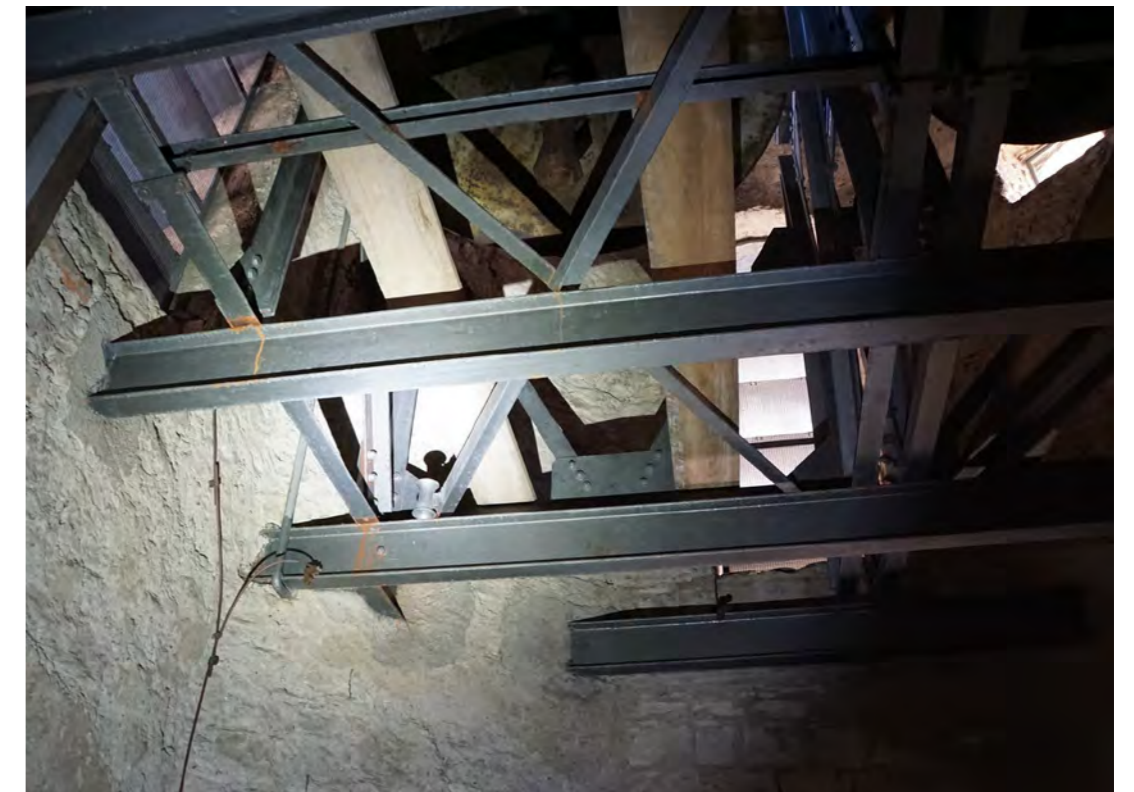
Abb. 2: Ansicht des historischen Glockenstuhls von unten
