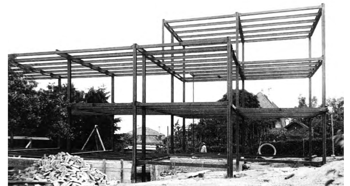
Abb. 1 und 2: Haus Colnaghi (Foto vom 9.1.2017) und Stahlskelett mit im Baugrund eingelassenen Profilstahlstützen
