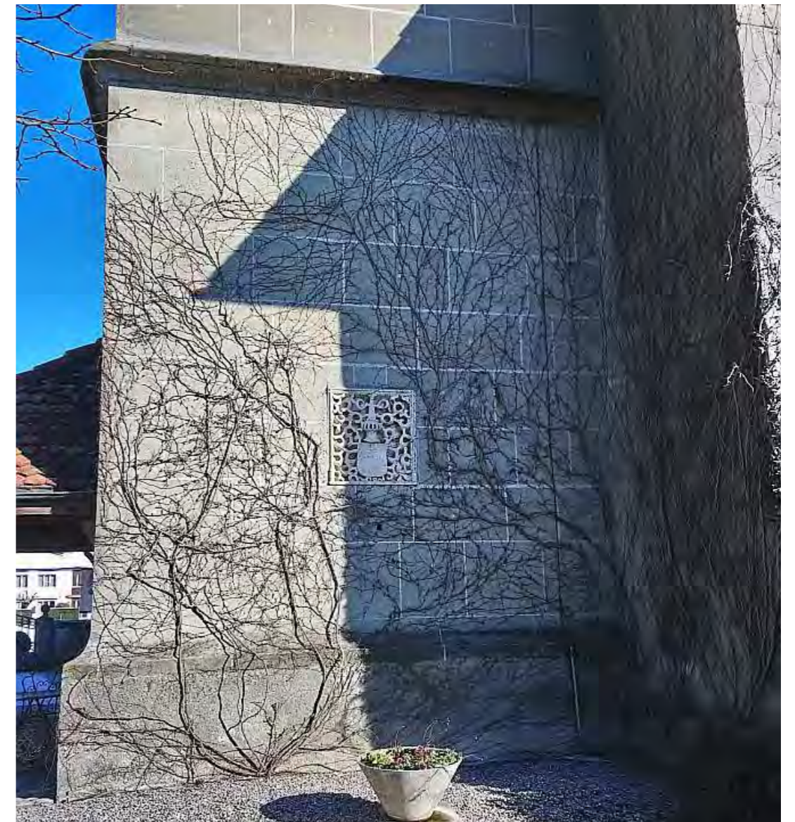
Abb. 14: Südfassade des Turms mit Bewuchs durch wilde Rebe
