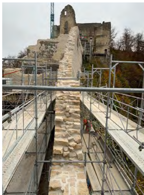
Abb. 8: Mauerkronenausbildung Mauer, 1.11.2020. Foto: GG
