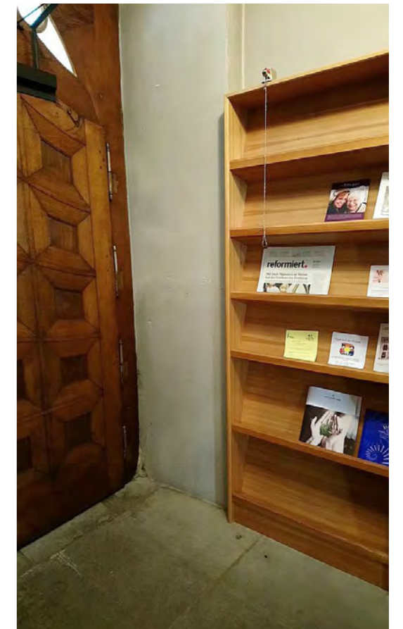
Abb. 10: Westliche Eingangstür, Nordhälfte
