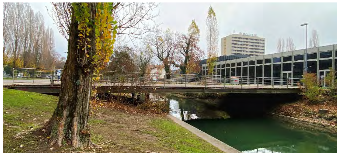
Abb. 12: Balkenbrücke über den Schüsskanal aus den frühen 1980er-Jahren, erstellt im Zusammenhang mit dem Gymnasium
