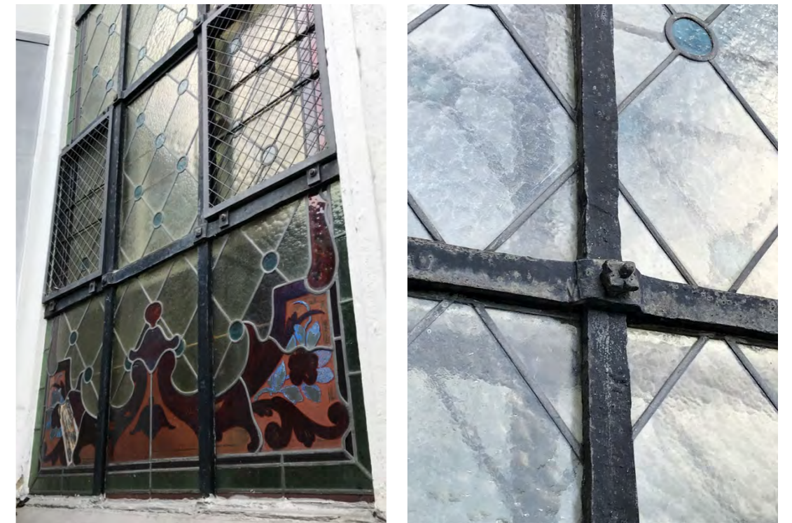
Abb. 6: Historische (barocke?) Eisenkonstruktion mit späteren Lüftungslügel bzw. Gittern. Cathedralglas mit bewegter Oberfläche
