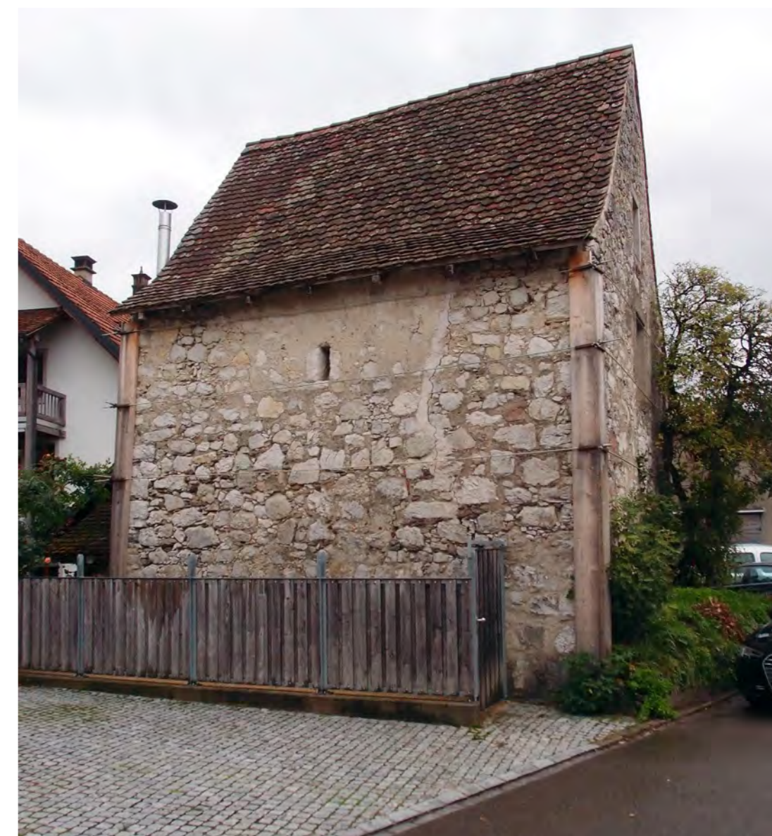
Abb. 1: Westfassade, Zustand am 4.10.2019
