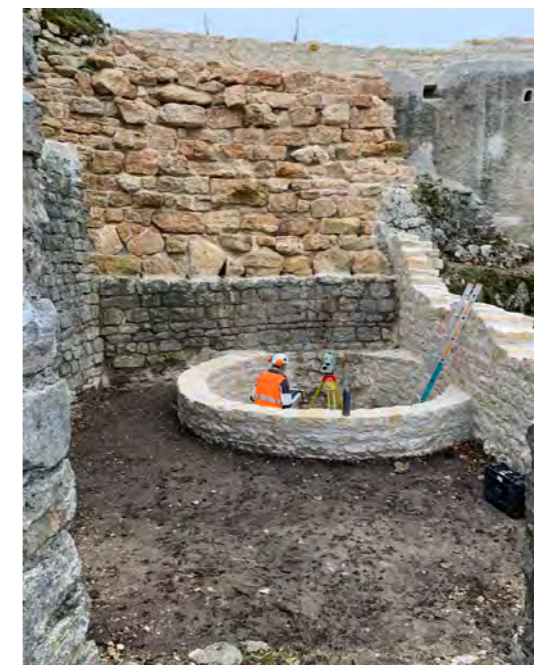
Abb. 9: Rekonstruierte Mauerkrone des Sodbrunnens (M 76) im Brunnenhaus. Blick nach Nordwesten. Foto: GG
