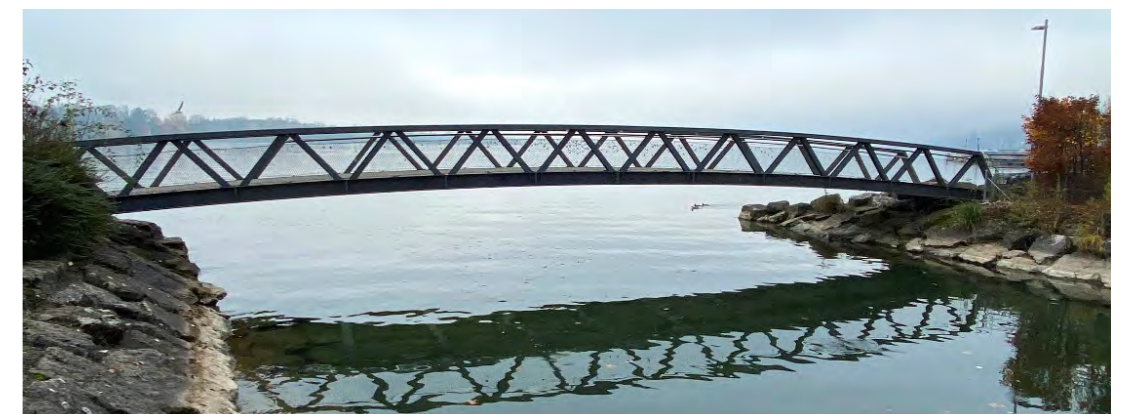
Abb. 17: Fachwerkbrücke aus Stahl über den Binnenhafen Seite Vingelz von 2014
