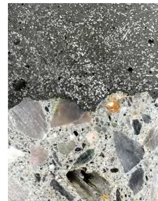
Abb. 26: Das Foto zeigt einen Ausschnitt einer Betonfahrbahnplatte einer Brücke, die mit einer UHFB-Schicht abgedichtet und verstärkt wurde. Der Unterschied zwischen UHFB (oben) und Beton (unten) ist offensichtlich.
