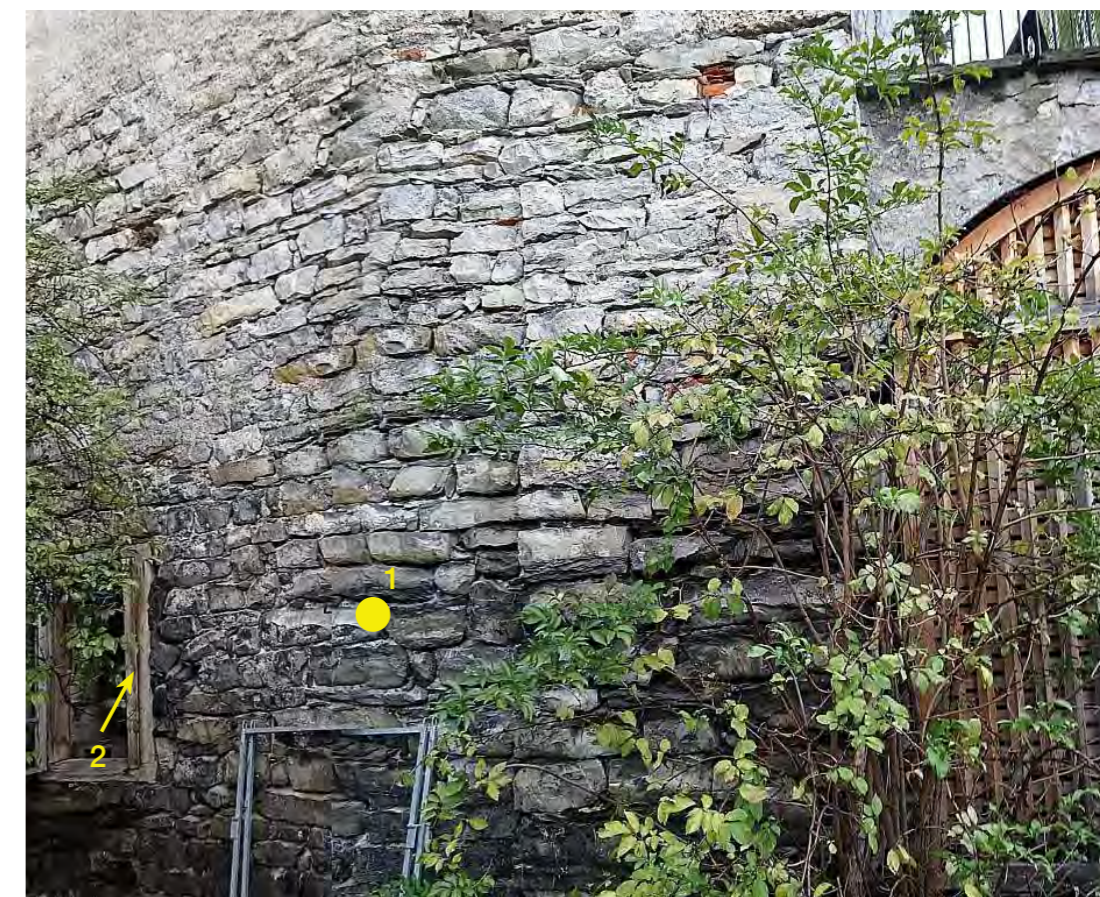
Abb. 3: Mauerfuss der Südfassade des Torturms mit Entnahmestellen der Proben 1 und 2
