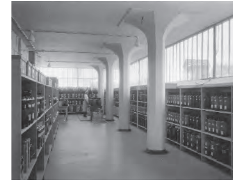
Abb. 7 und 8: Die grosszügigen Räume in Bau 27 bieten eine gleichmässige Belichtung für unterschiedlichste Nutzungen (links: Pilzstützen im Nordteil; rechts: Fassadenstützen im südlichen Anbau).
