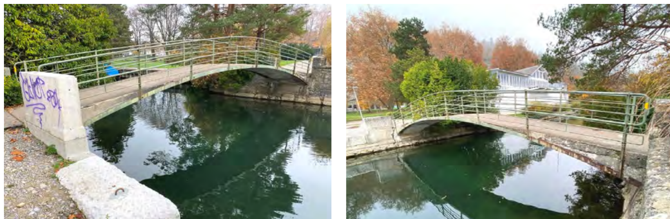
Abb. 18 und 19: Ansicht der Neptunbrücke. Die Neigung der Auffahrt beträgt etwa 8 % gegenüber der Horizontalen.
