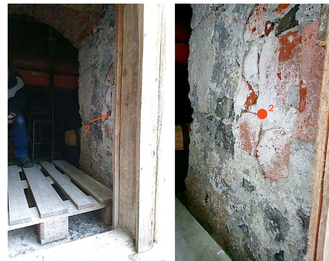
Abb. 4: Details der Entnahmestelle von Probe 2. In diesem Bereich und unter der Torbrücke soll sich früher ein Pony-stall befunden haben.
